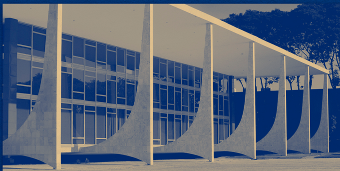
Detalhes da fachada do edifício-sede do Supremo Tribunal Federal.
